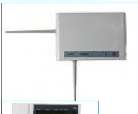
Приемно-контрольные приборы «РРОП-И» и «РРОП-М2» – установлены на стенах согласно проекта АПС. Прибор контролирует состояние датчиков и формирует в случае извещения ПОЖАР сигналы управления на исполнительные устройства («Орфей-Р» и «Табло-Р»).
